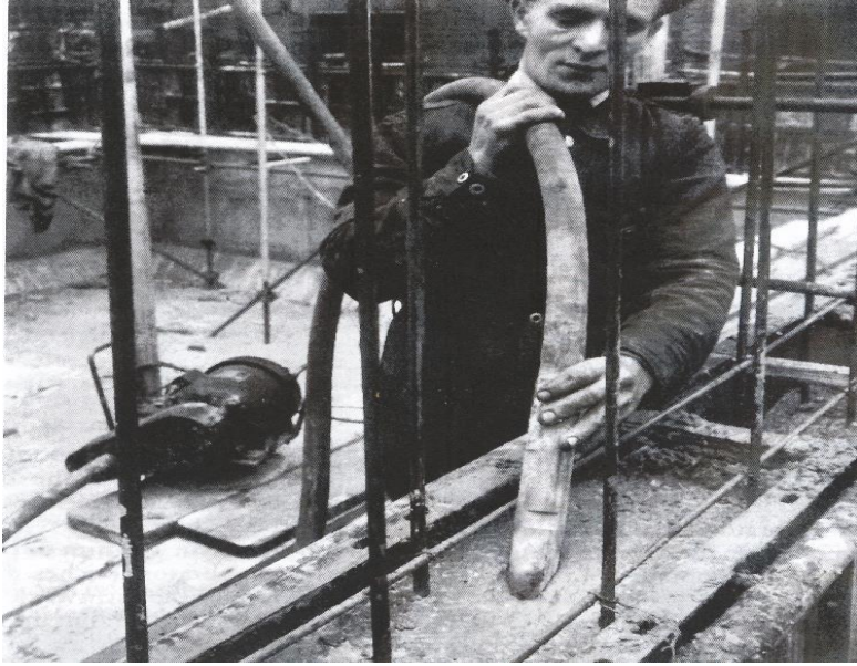
الشكل ( 43 - 2 ) رج الببتون باستخدام الرجاج الداخلي
