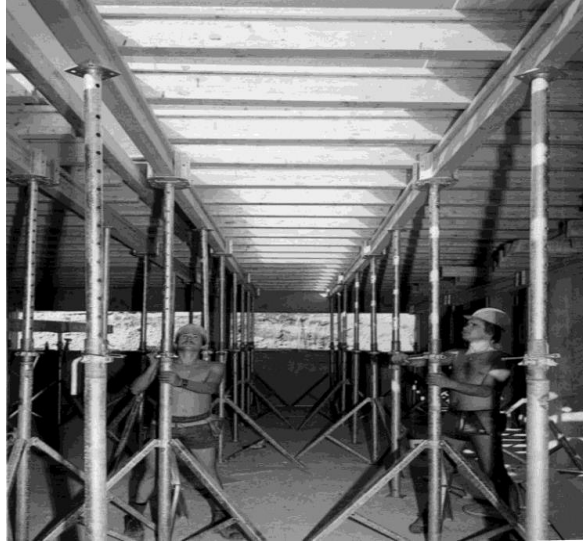
الشكل ( 9 - 2 ) قالب سقف محمول على سفالة معدنية وركائز تسكوبية .
