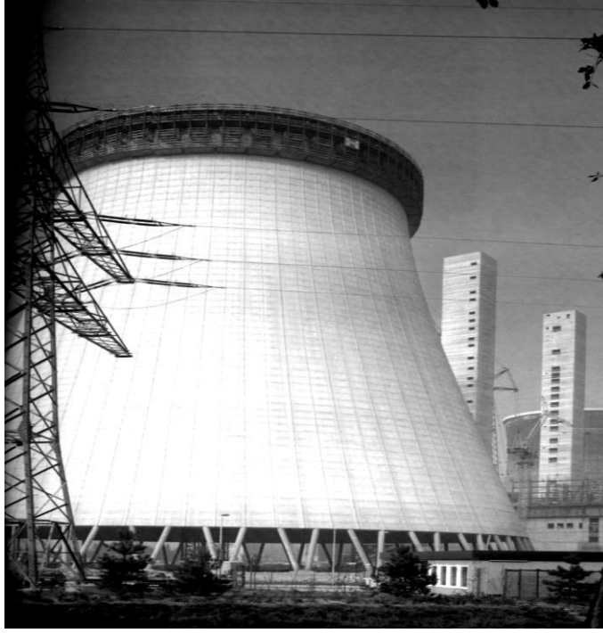
الشكل ( 2-17 ) برج لتبريد الماء نفذ بطريقة القالب المتسلق ذي المكبس الهيدروليكي.
