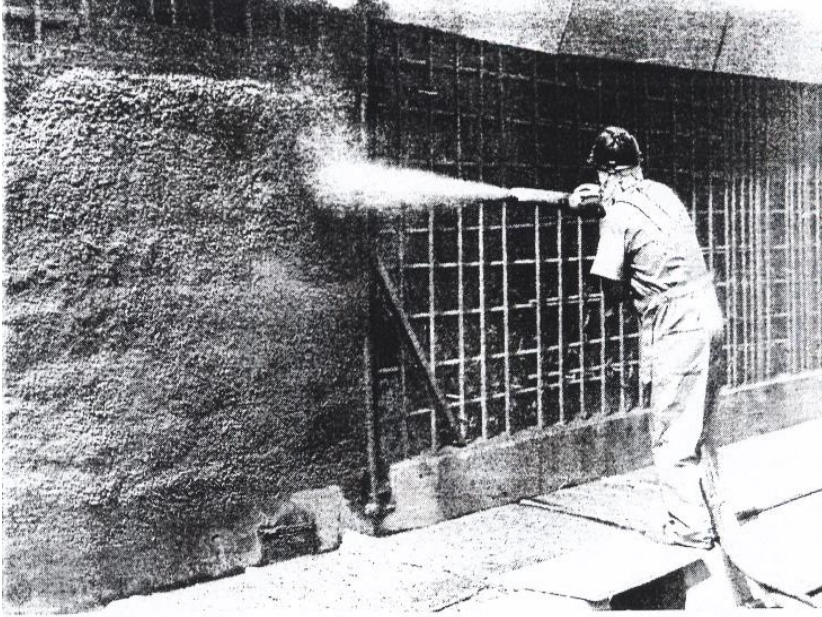
الشكل (2- 37) رش المونة الإسمنتية على جدار خزان بيتوني يتم إصلاحه.
