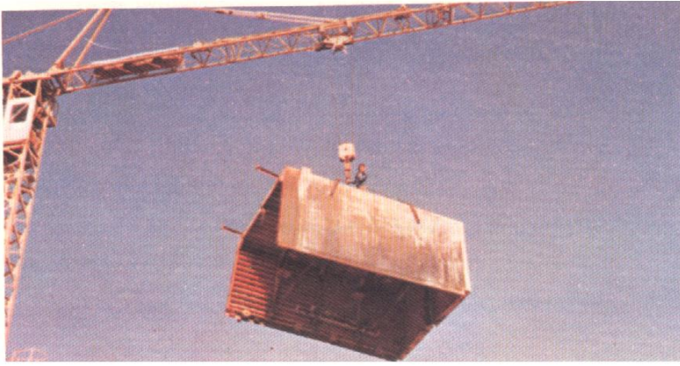
الشكل ( 16 - 2 ) دورة عمل القالب النفقي
